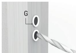
**7.** Fermer les pênes afin que les disques adhésifs se collent au cadre de la porte. Percer les trous sur le cadre de la porte en prenant référence le centre des disques adhésifs. Utiliser des outils adaptés en fonction du matériau. Utiliser les disques (G) comme modèle pour percer les trous. Ne pas dépasser les dimensions du modèle.
